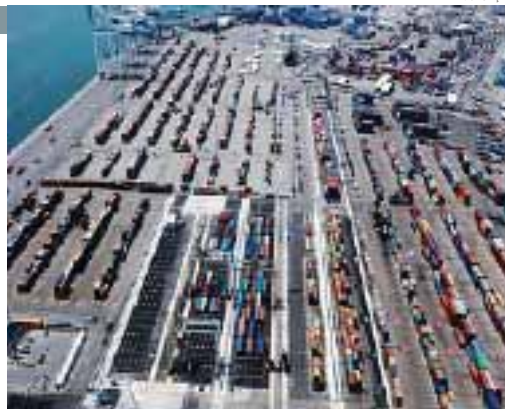
OEC foi responsável por reforçar estruturas para guindastes no porto
