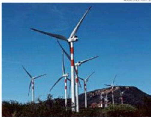
Empresa já tem 10 parques eólicos em operação em Sento Sé
