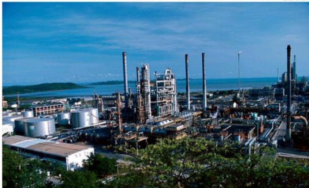
Localizada em São Francisco do Conde, a Refinaria Landulpho Alves (Rlam) possui capacidade de processamento de 323 mil barris por dia
