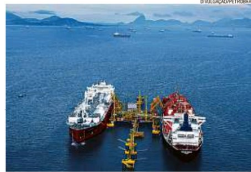
Foto. Terminal de regaseificação de GNL: produto responde por 27% do consumo
