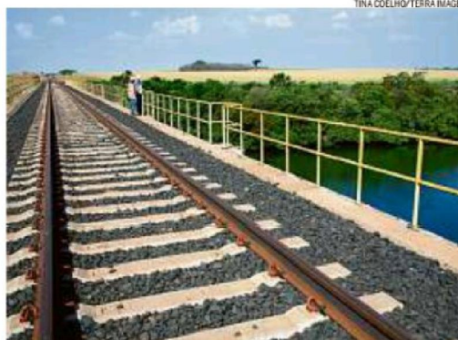
Alternativa. Ferrovia Norte-Sul: ligação à estrada permitiria escoamento de safra
