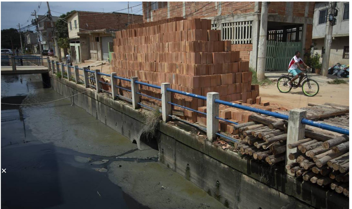
Esgoto sem tratamento: Decreto prevê capacidade de investimento das empresas para cumprir metas Foto: Márcia Foletto / Agência O Globo
