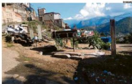
Abandona. A área do Fé, em Teresópolis, à espera de obras de contenção desde as chuvas de 2011
