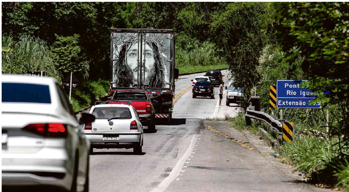
Pista na BR-101, entre Mangaratiba e Angra dos Reis (RJ); trecho foi classificado pela CNT como ruim, principalmente por causa da pavimentação e geometria da via. Eduardo Anicelli/Folhapress
