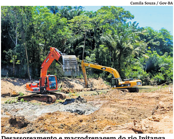
Desassoreamento e macro drenagem do rio Ipitanga
