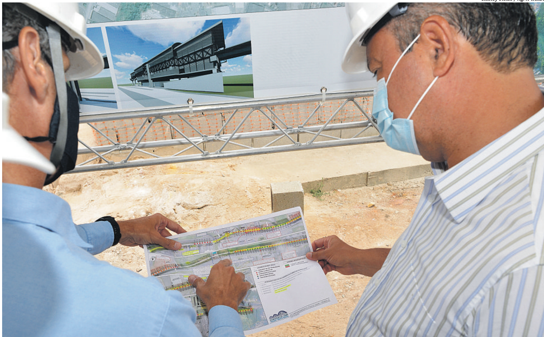
Rui Costa falou sobre a retomada das aulas no estado, ontem, durante uma vistoria às obras do tramo 3 da Linha 1 do Metrô de Salvador
