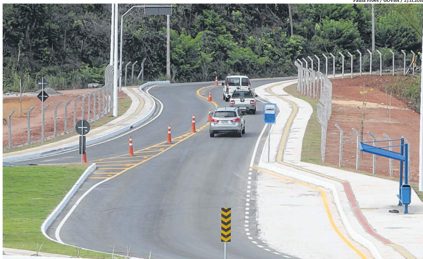
Obra é fruto do investimento de R$ 580 milhões do governo do estado: motoristas elogiam acessibilidade
