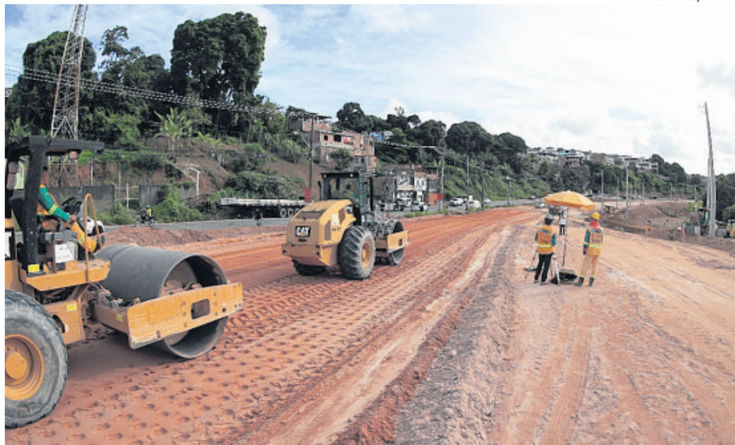
Obra viária liga toda a orla marítima, saindo de Piatã ao encontro da BR-324
