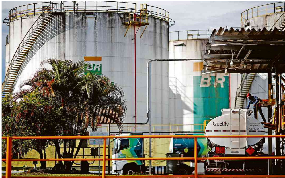
Tanques em refinaria da Petrobras no DF; Comsefaz diz que decisão do Supremo pode elevar preço do diesel em até R$ 0,20, em média Adriano Machado - 14.mar.22/Reuters
