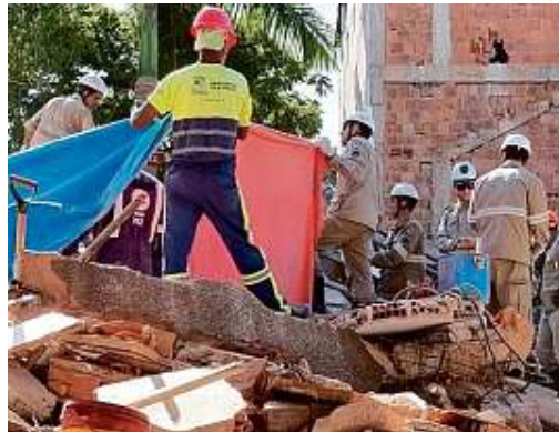
Resgate trabalha nos escombros de prédio que explodiu em Vila Velha
